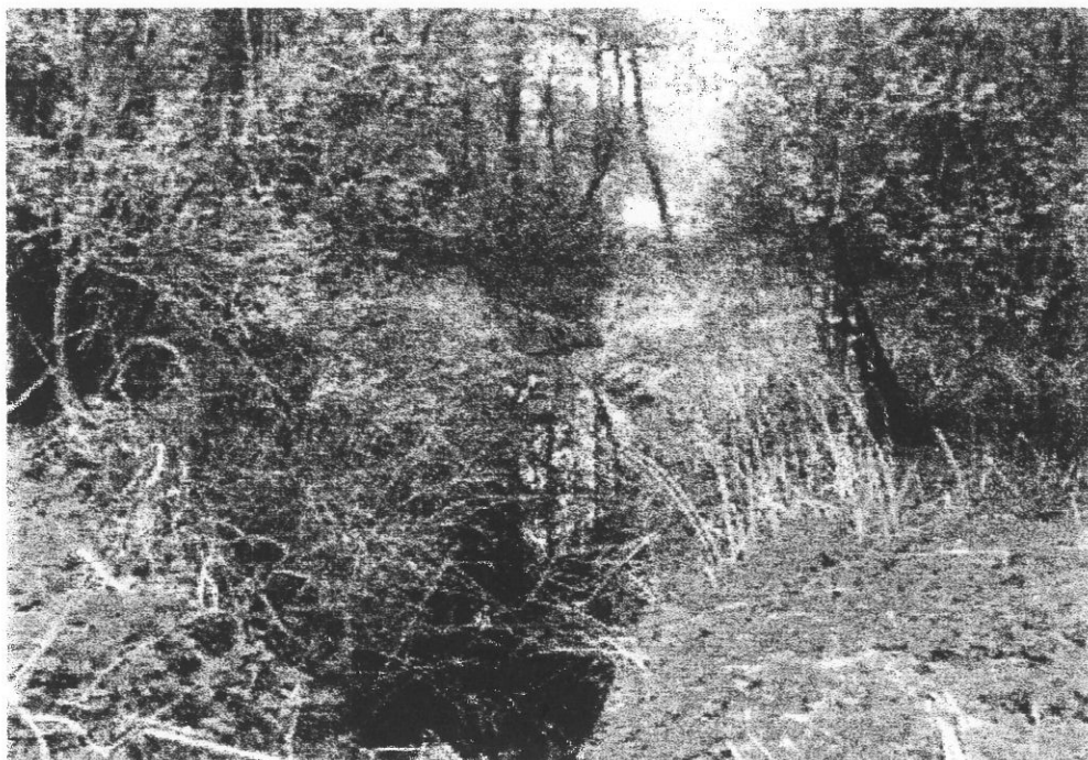
Kommunevandløb nr. 18, ved Nykøbingvej udfor Idalundsvej
