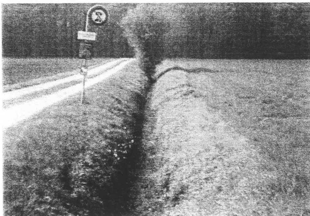
Kommunevandløb nr. 32, ved Kongstolpevej
